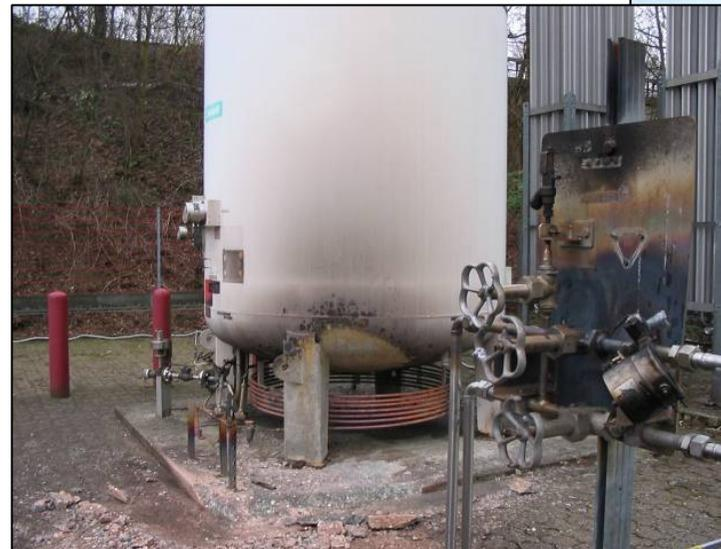
Fundamentschäden durch H<sub>2</sub>-Brand
